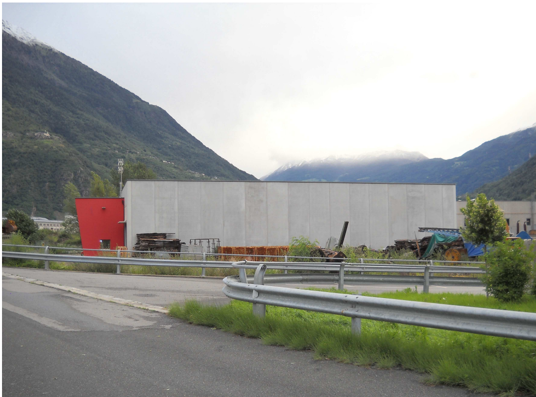
Foto 2: Ancora vista da ovest dell'ingresso all'area
