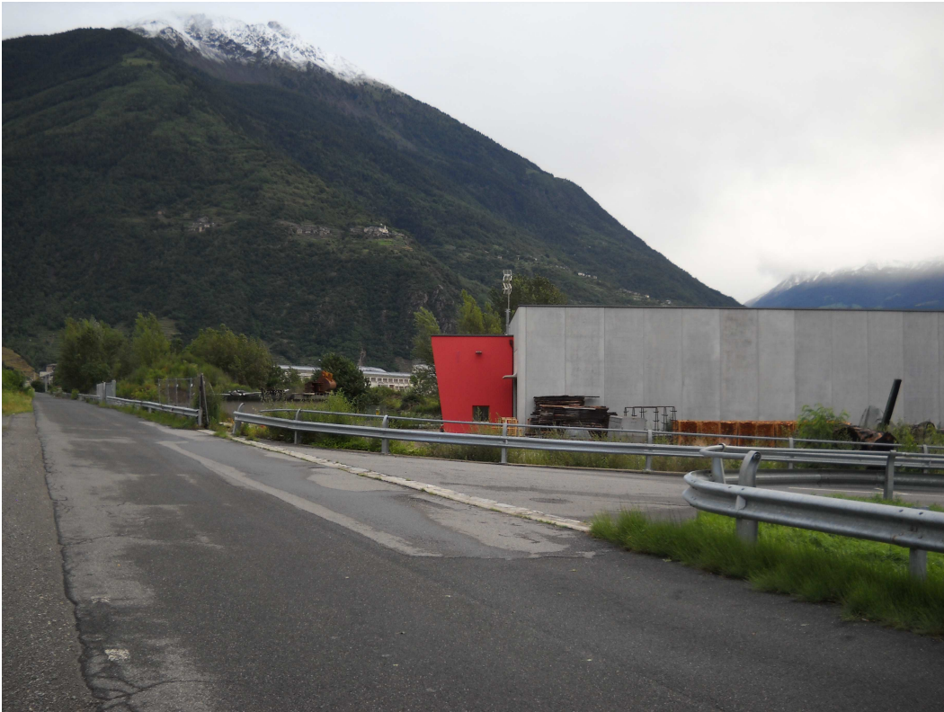
Foto 1: Vista da ovest dell'ingresso all'area
