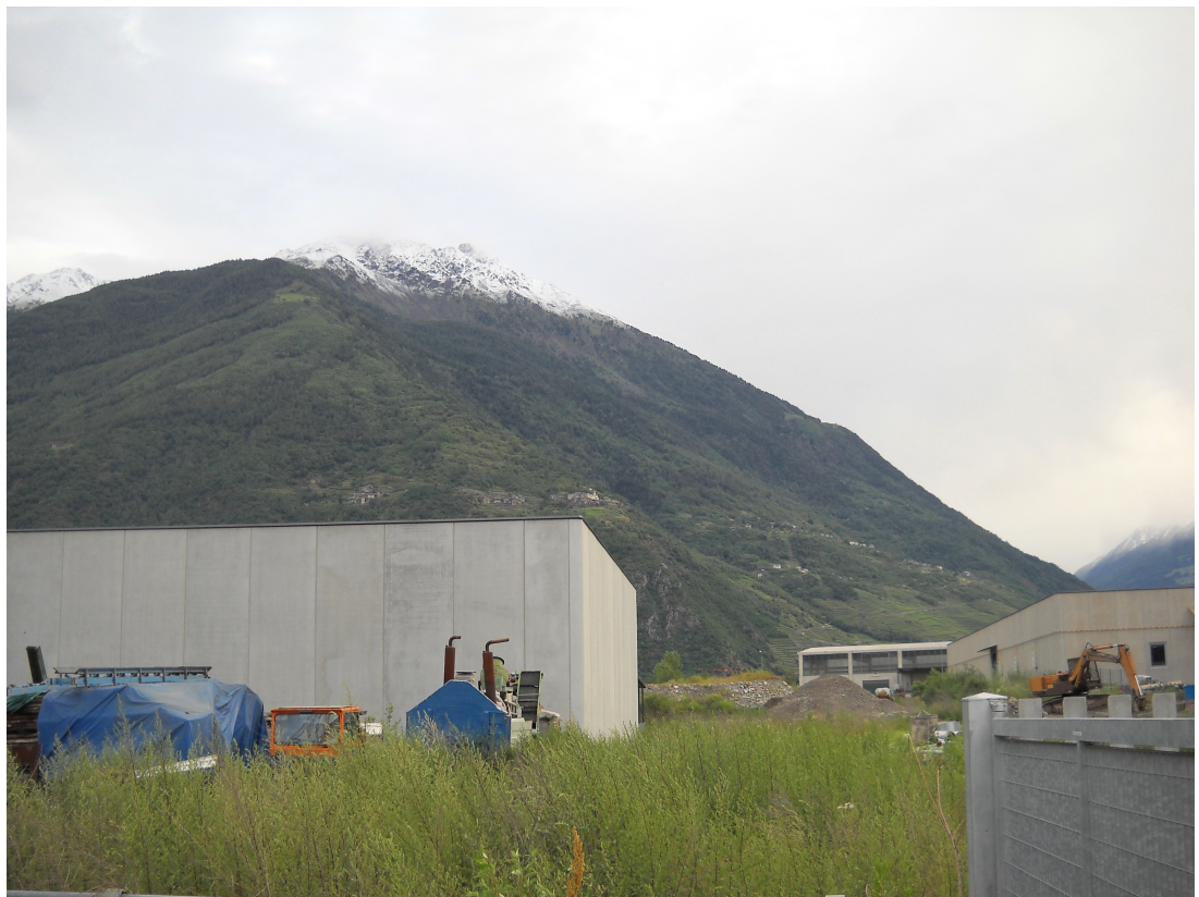
Foto 4: Vista della zona in cui sorgerà l'area con i container
