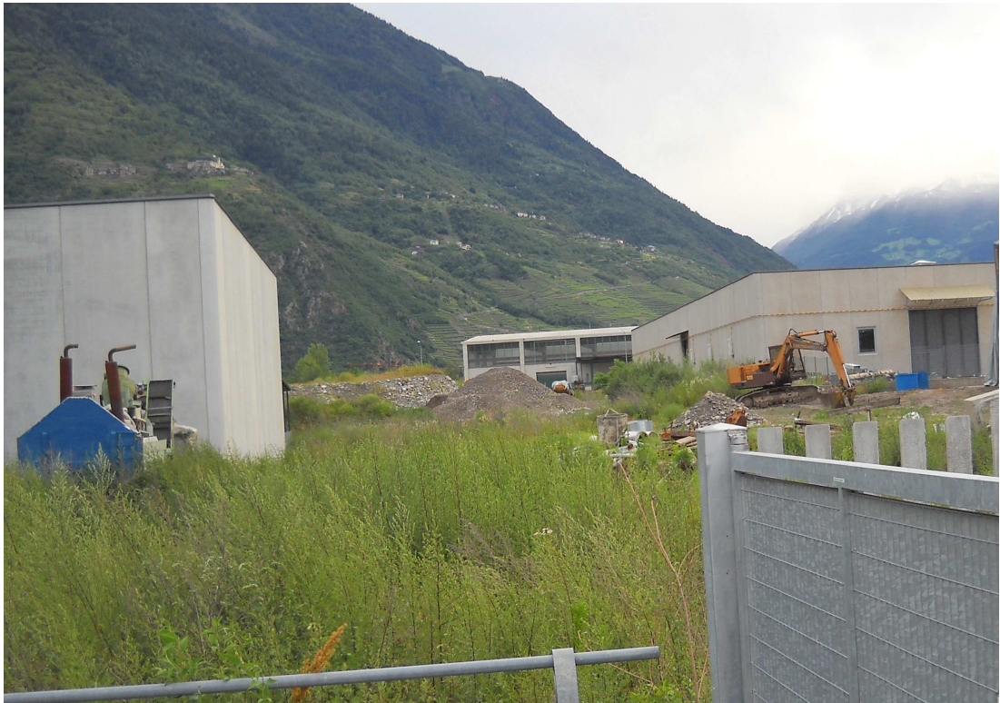
Foto 3: Vista della zona in cui sorgerà l'area con i container
