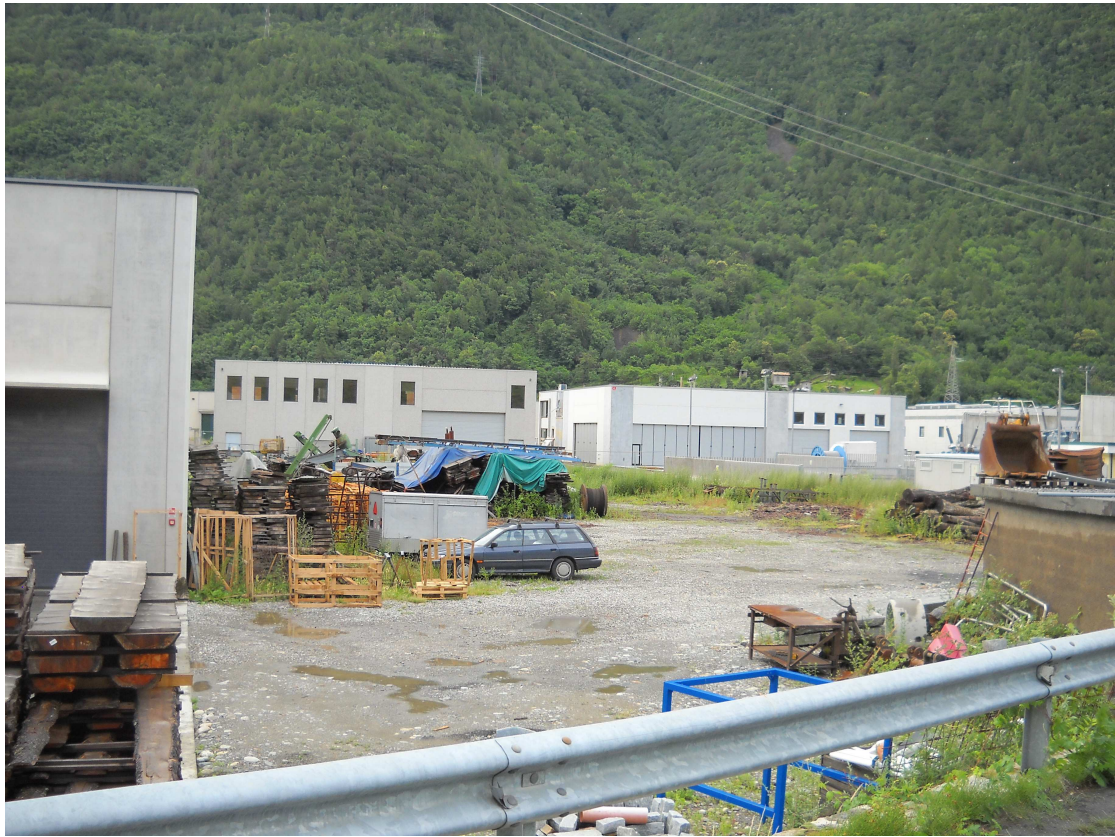
Foto 5: L'ingresso al nuovo capannone a servizio dell'area adiacente all'esistente
