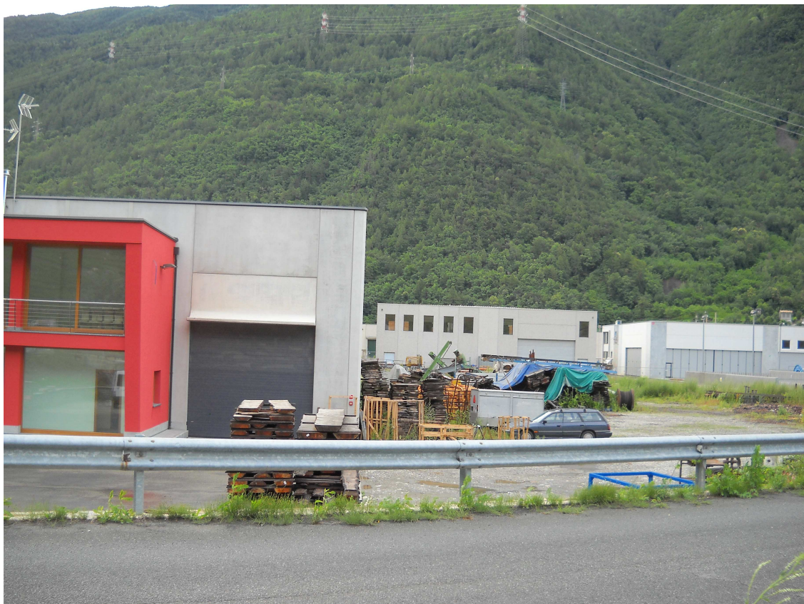
Foto 6: Vista del fronte del capannone esistente adiacente
